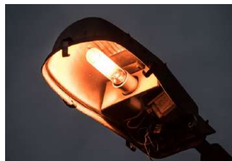
Rénovation et extension de l'éclairage public 40 000 €
