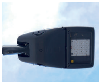
Rénovation et extension du réseau d'éclairage public : 36 514, 74 €
