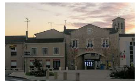
Travaux de couverture salle du Conseil Municipal 25 000 €
