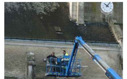
Remplacement de la couverture du presbytère et audit du beffroi de l'Église 32 000 €
