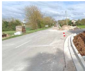
Aménagement de la voirie 275 000 €
