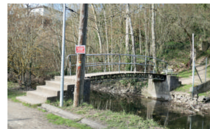
Début de l'installation d'une nouvelle passerelle chemin de la piscine : 19 548 €
